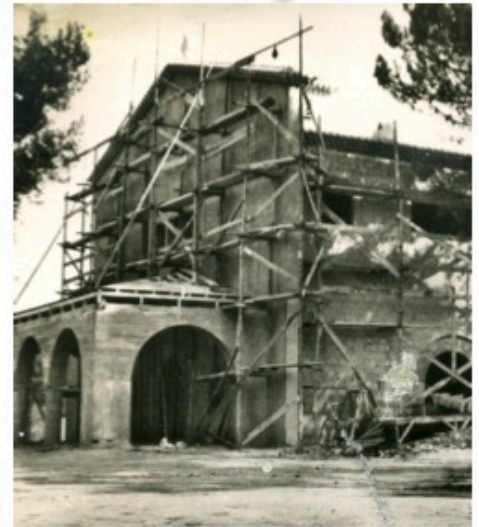
L'église Sainte-Bernadette en construction
